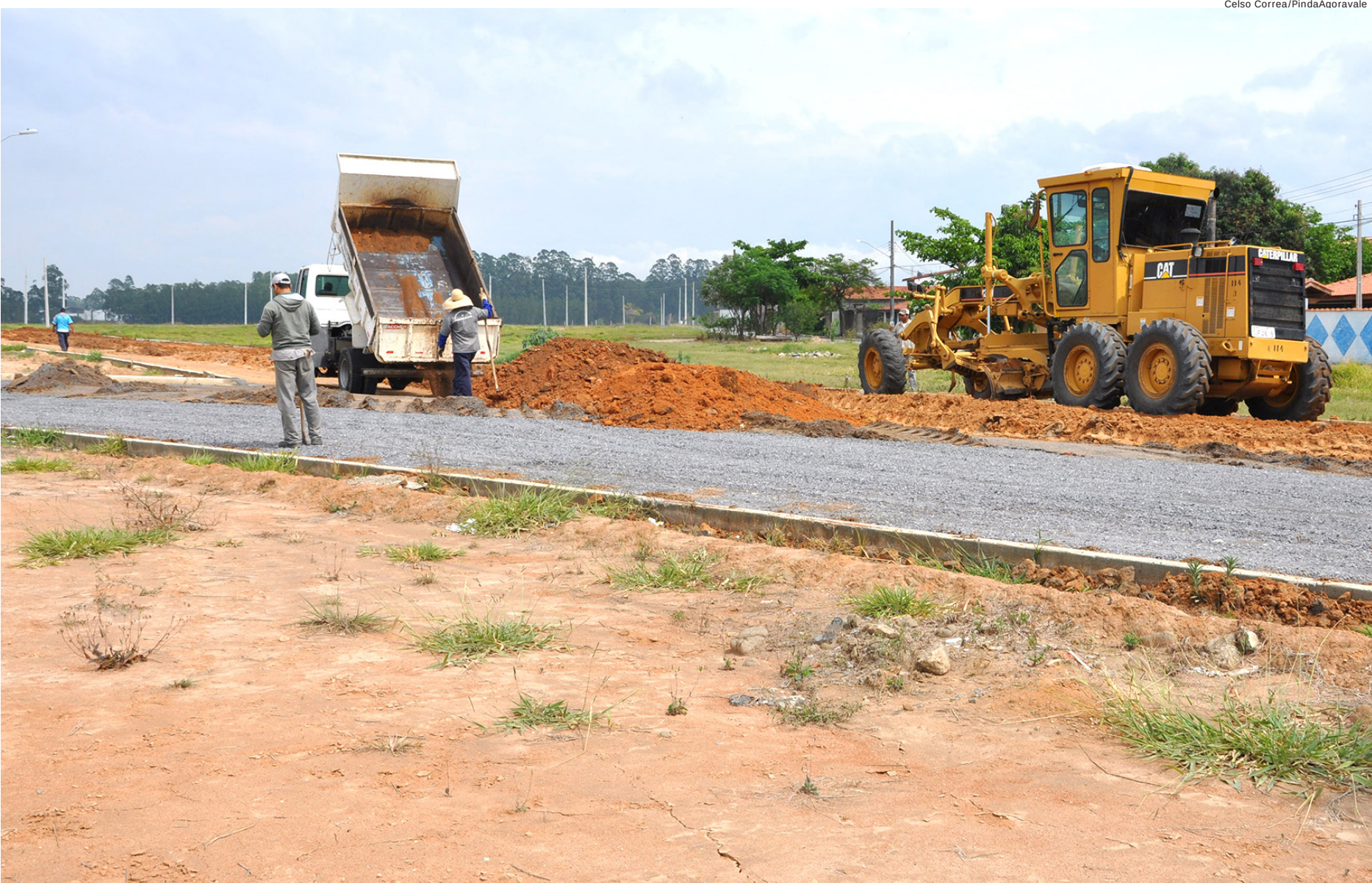
Equipe da subprefeitura realizando as melhorias na Avenida Nova Pinda, importante via de acesso à vários bairros
