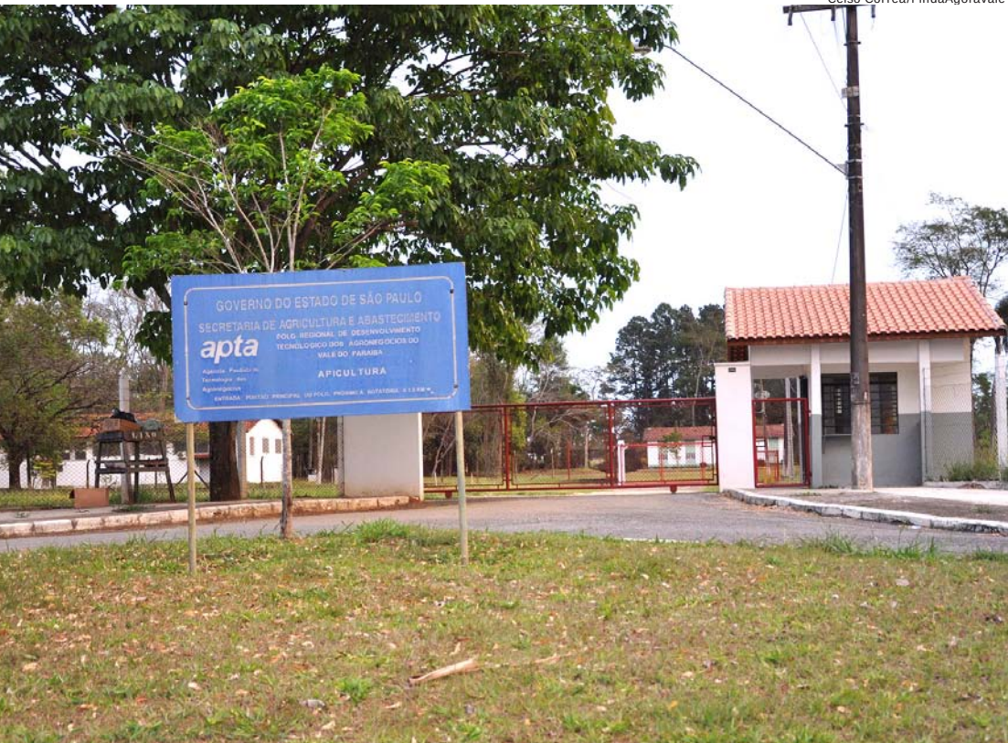
Nova portaria da Apta, construída na avenida Manoel César Ribeiro, nº 1.620, próxima à rotatória do “Maricá”
