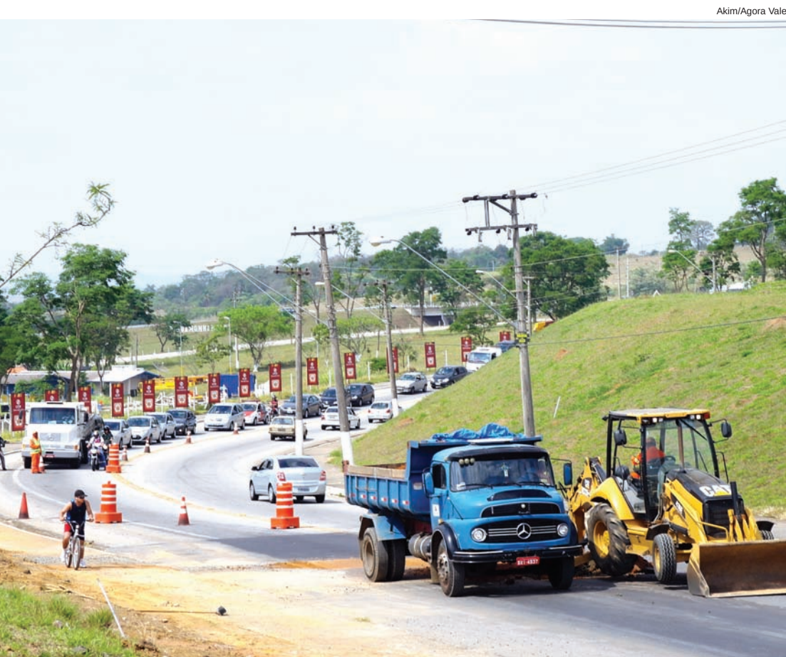
Obras de duplicação da avenida já estão em andamento
