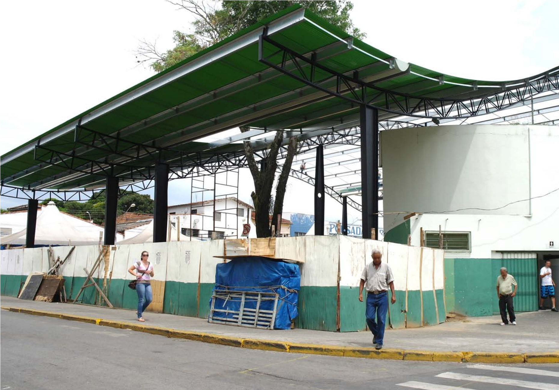
Cobertura da feira está recebendo as telhas termoacústicas. A área coberta é de aproximadamente 1.700m²
