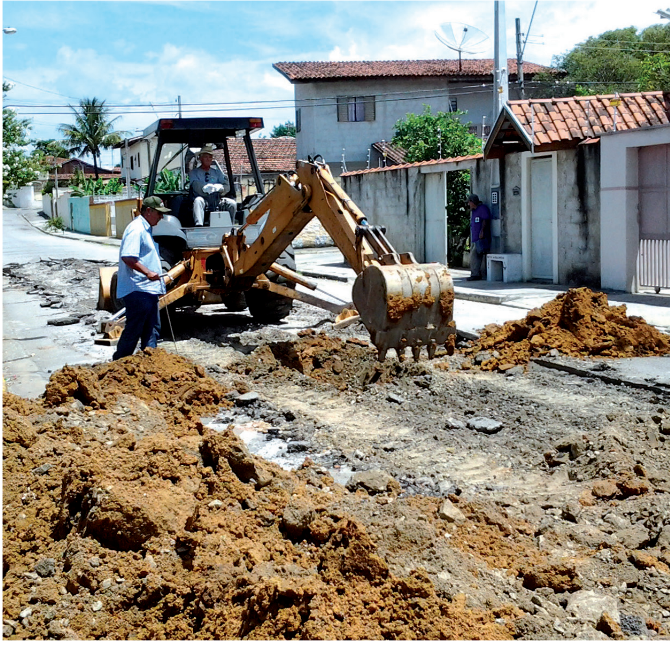
Prefeitura inicia perfuração de rua para instalação da nova tubulação de águas no Campo Alegre
