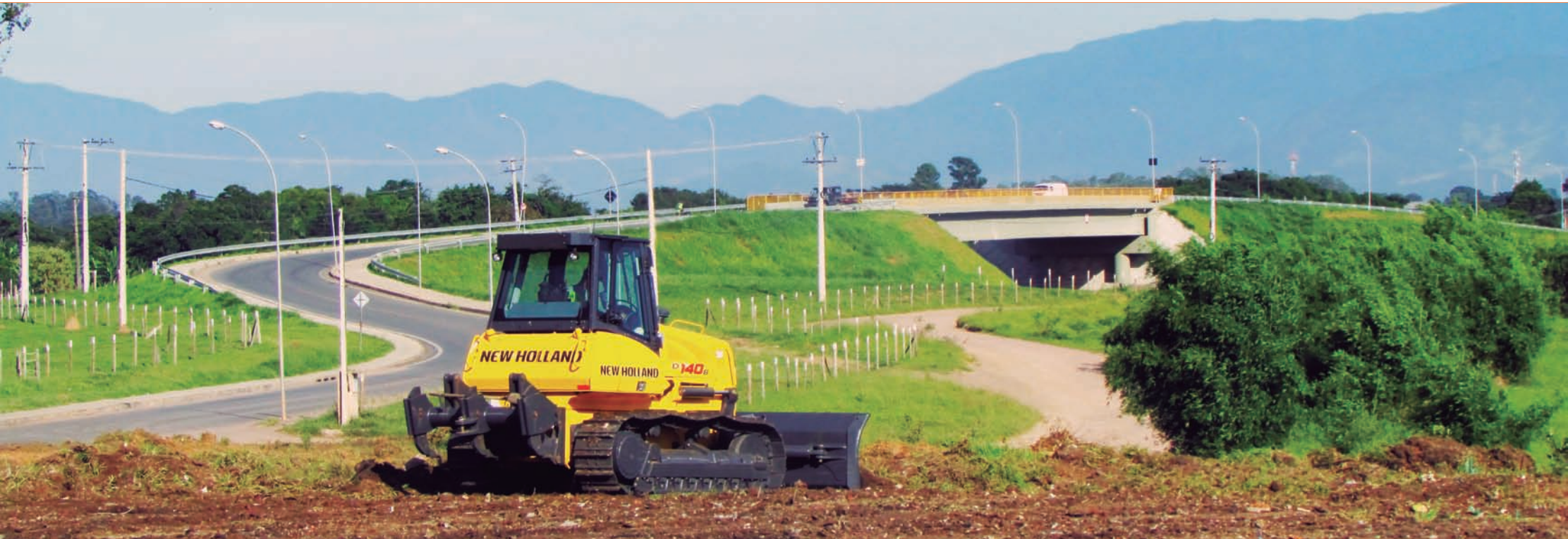
Trator de esteira realiza a limpeza vegetal, preparando o local para receber a terraplanagem
