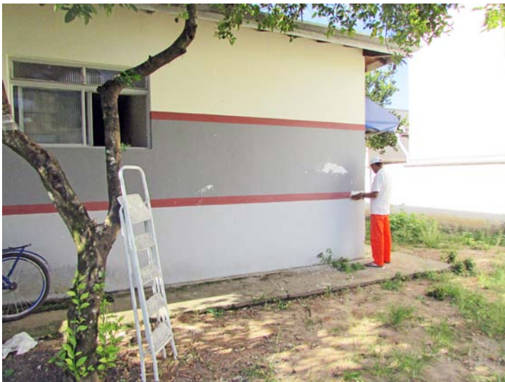
Preparação do prédio para receber a pintura
