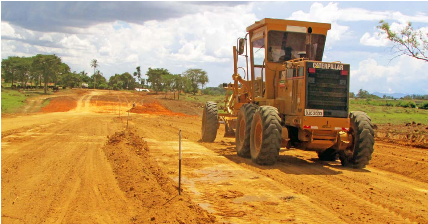
Área está recebendo a terraplanagem e nivelamento de solo
