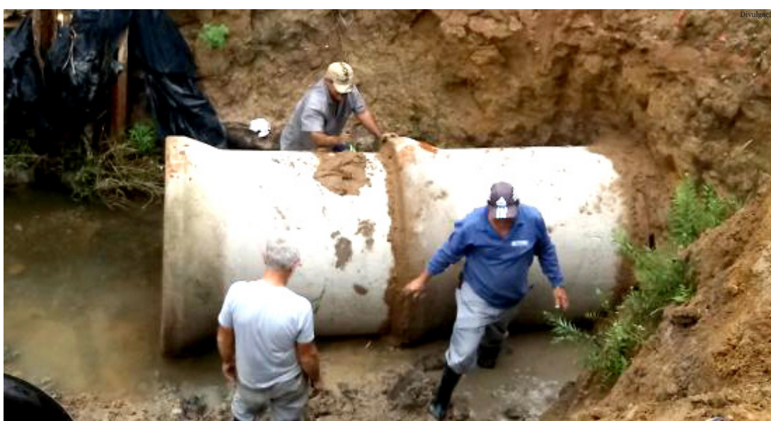
Reparo em galeria da rua Condessa de Vimieiro
