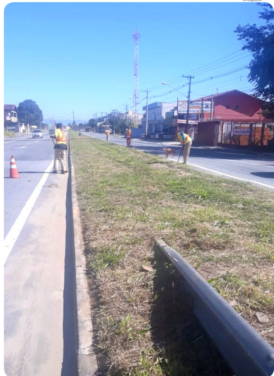
Obras estão sendo feitas através de convênio com a Funap
