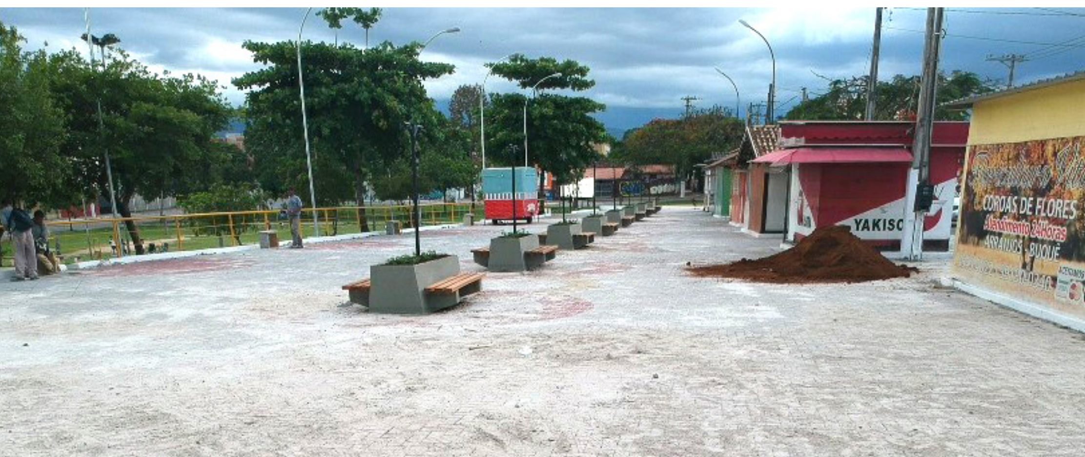
Praça recebeu piso novo, bancos, floreiras, além de melhorias elétricas e hidráulicas
