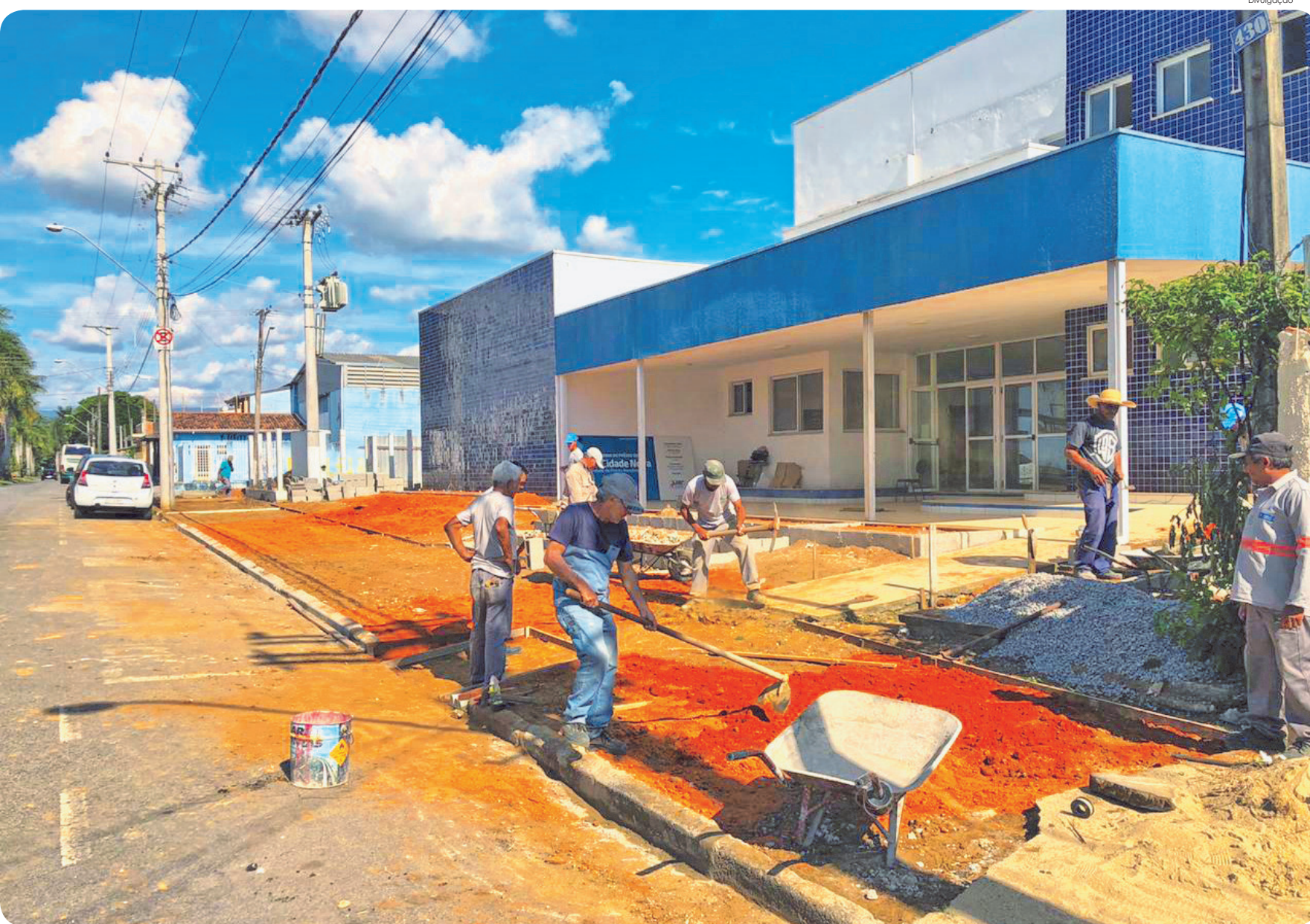
A Unidade de Pronto Atendimento está em fase de finalização das instalações elétricas
