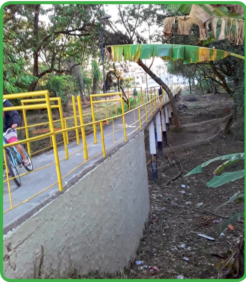
Passarela do bairro Mombaça também foi revitalizada
