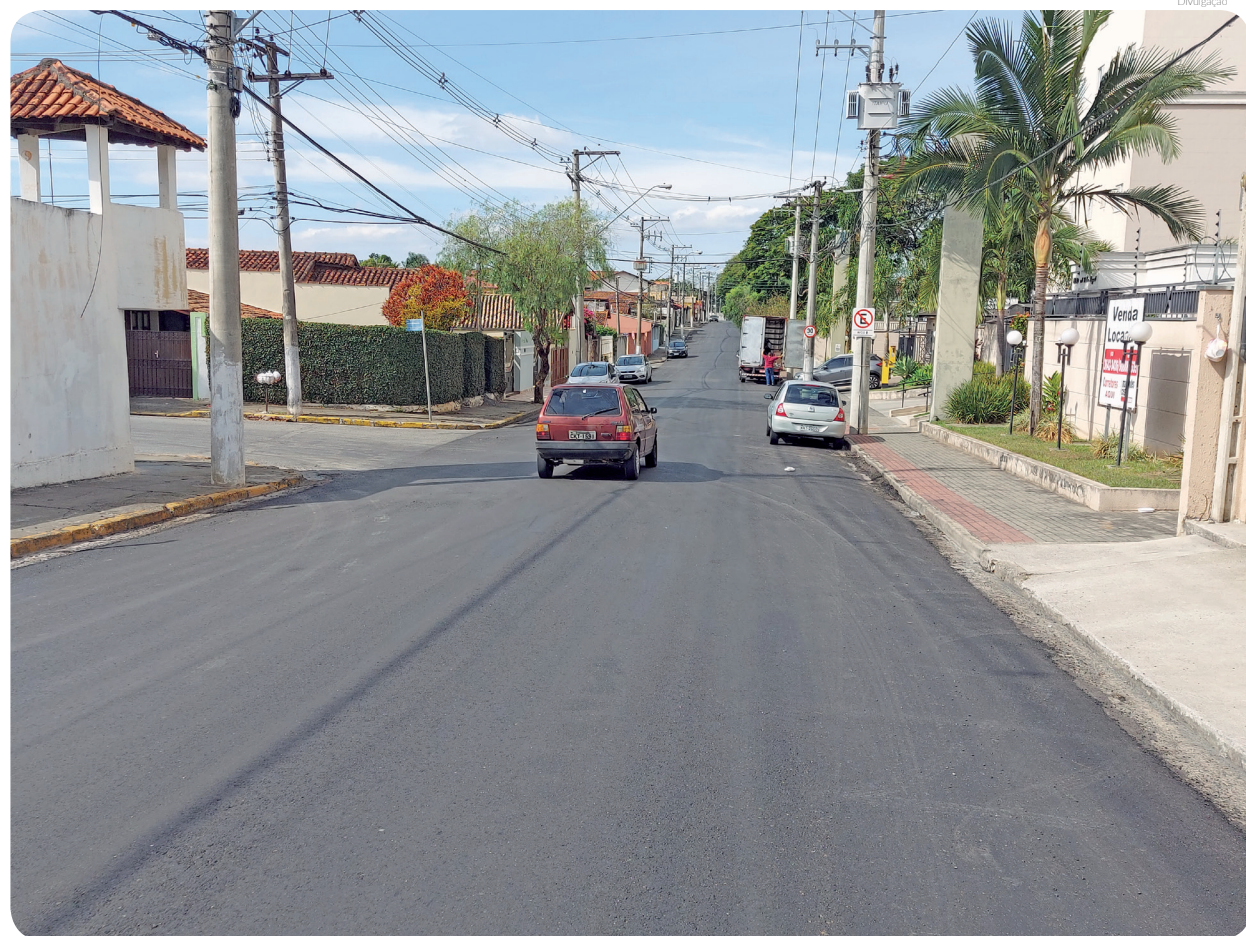
As obras prosseguem, com prioridade para as ruas em que o recapeamento é mais urgente
