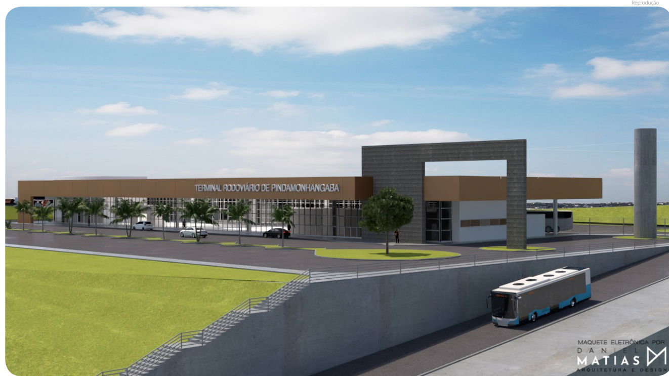
A rodoviária terá uma área de 9.700m 2 , entre plataforma e área de circulação e o prédio com 1.860m 2
