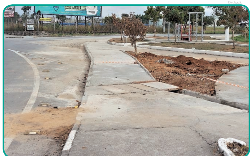
Região da rotatória Mazzaropi está recebendo melhorias
