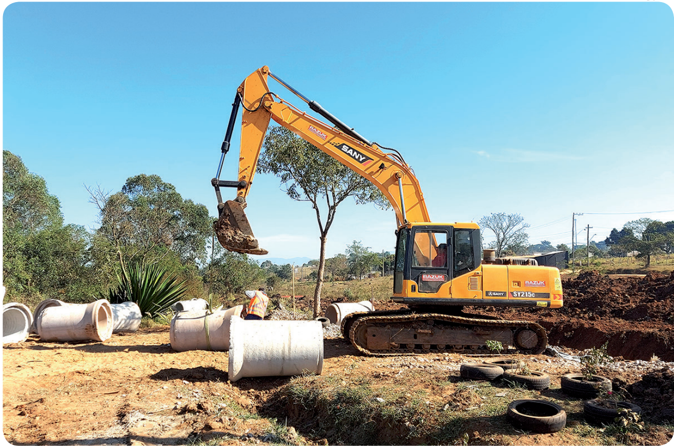
O canteiro de obras está sendo preparado com a construção das bocas de lobo e da tubulação para captação de água
