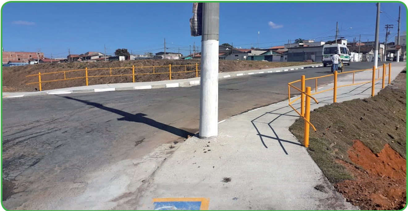
Localizado no Araretama, o valetão do Residencial das Américas teve o primeiro guarda-corpo instalado
