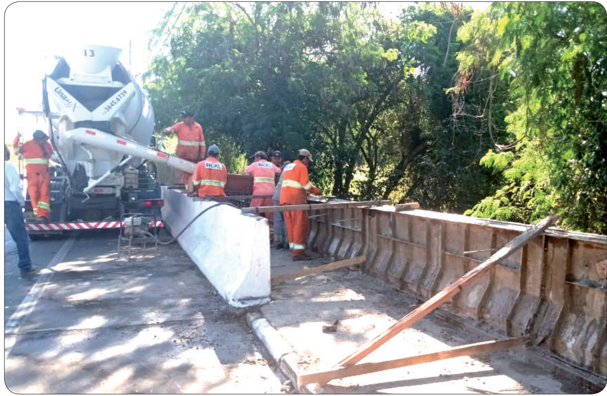
O Córrego do Curtume está recebendo a construção de novo guarda corpo em alvenaria
