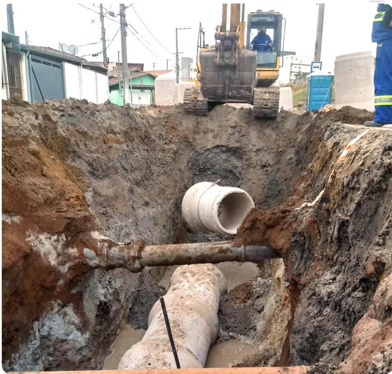
As obras tiveram início no final de junho e prevê a substituição de 230 metros de galeria com maior diâmetro para melhor captação de água
