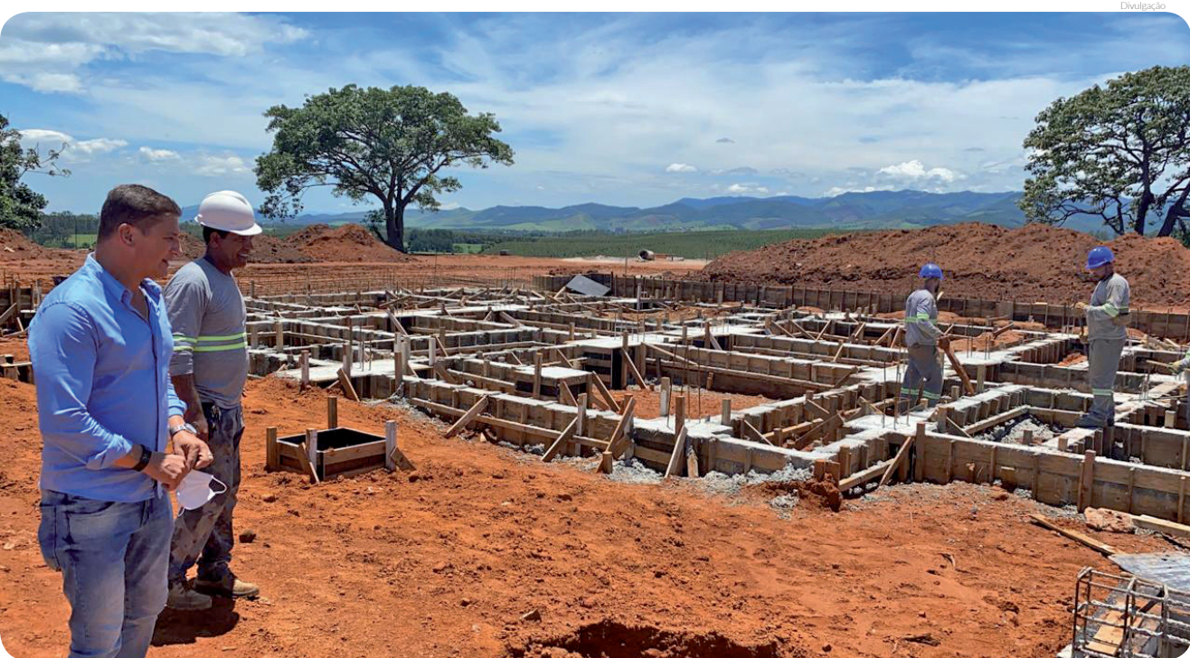
Novo terminal rodoviário - às margens da Dutra - em fase de fundação, se prepara para receber as estruturas pré-moldadas
