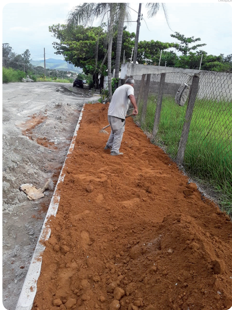
Zeladoria executa serviço de assentamento de guias
