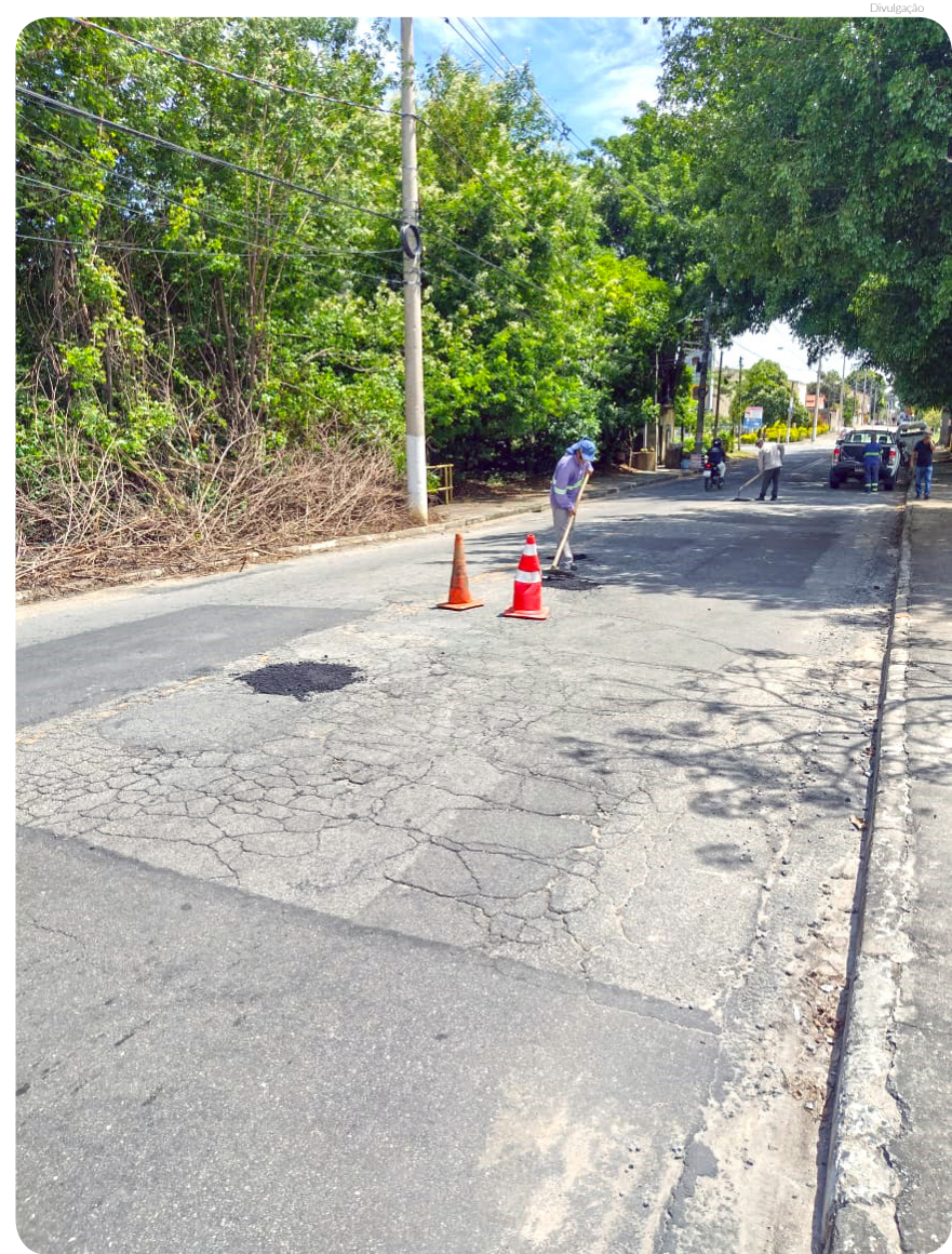
A operação Tapa Buraco prossegue no distrito de Moreira César
