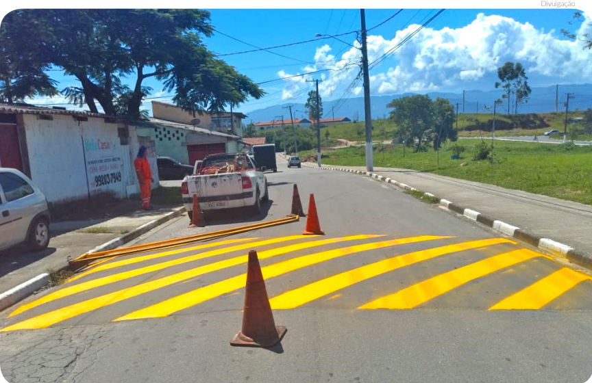
Deptran realizou sinalização de diversas lombadas
