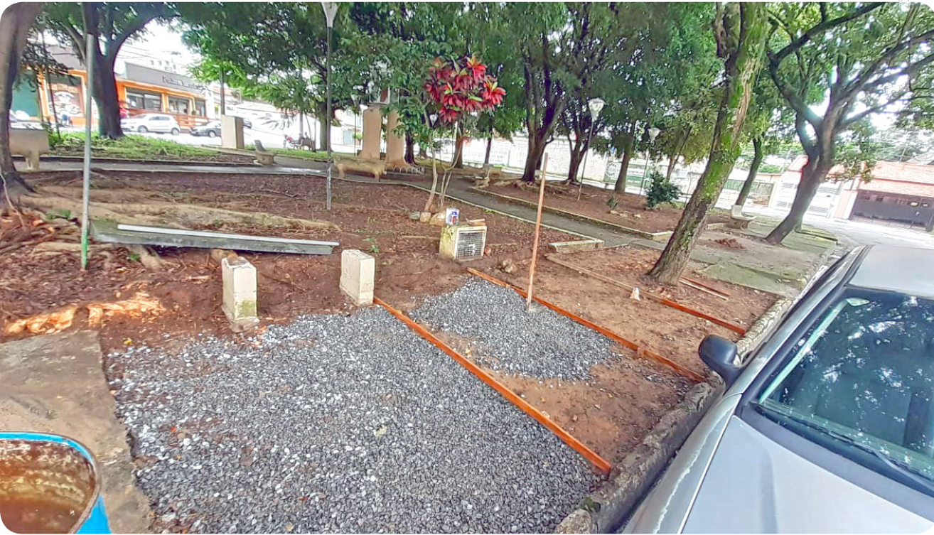
Praça Santa Luzia ganha novo visual e maior conforto com a reconstrução de calçadas
