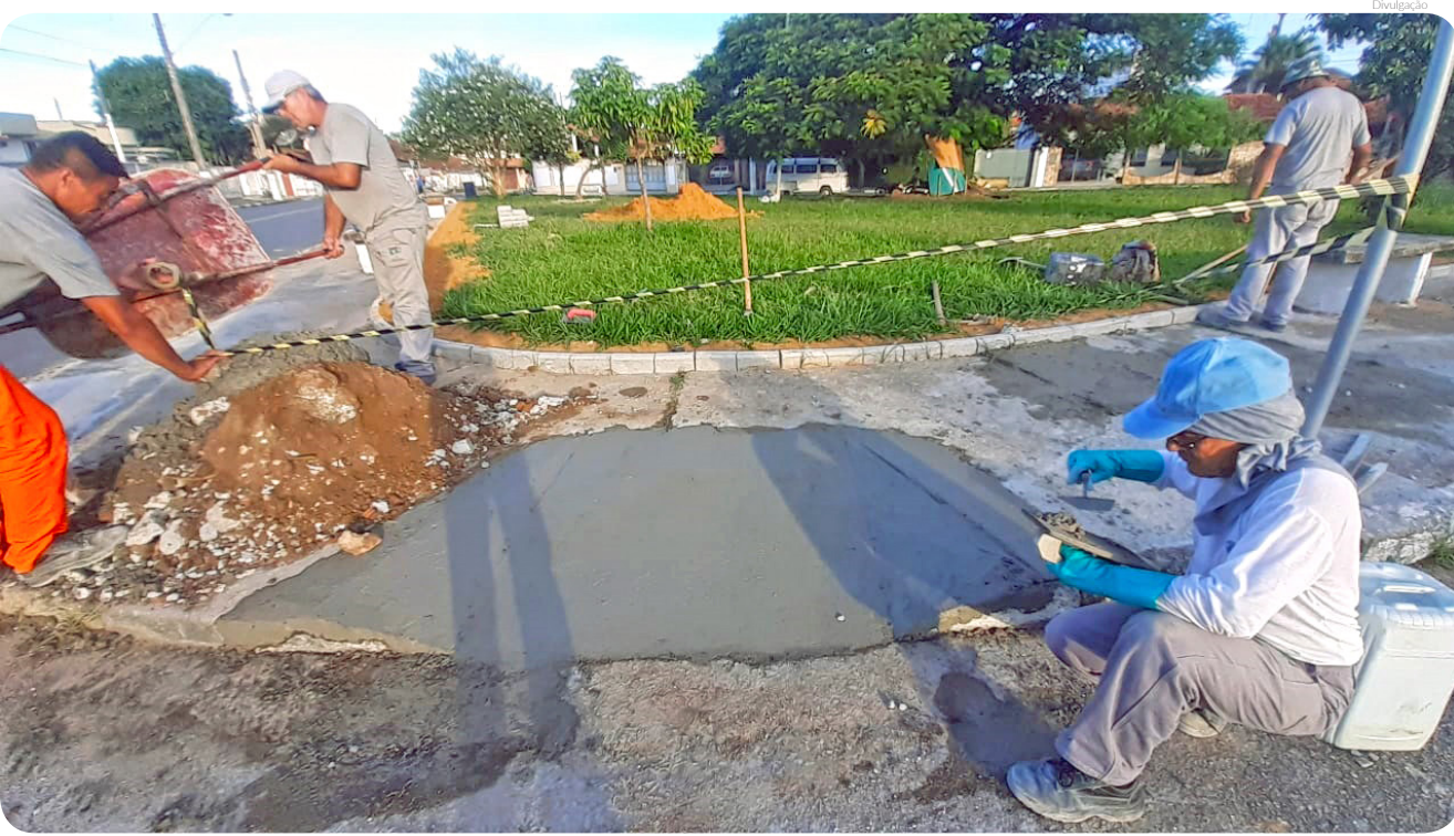
No Parque São Domingos, praça do bairro recebeu serviço de reforma e manutenção
