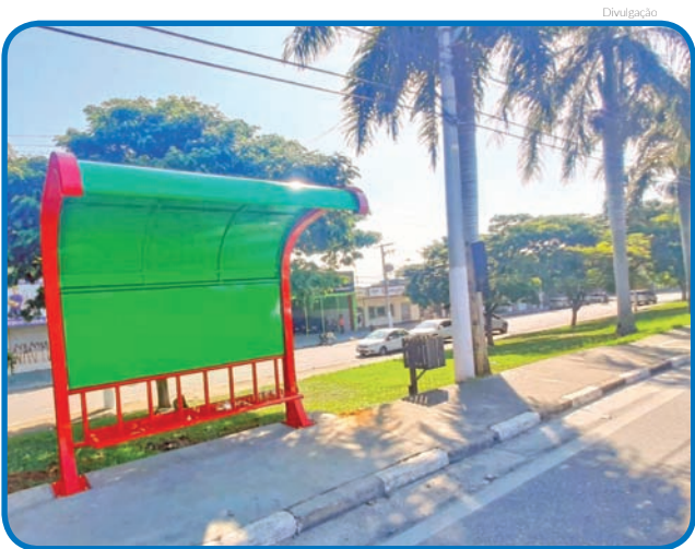
Novos abrigos para passageiros de ônibus são instalados na Av. NS Bom Sucesso
