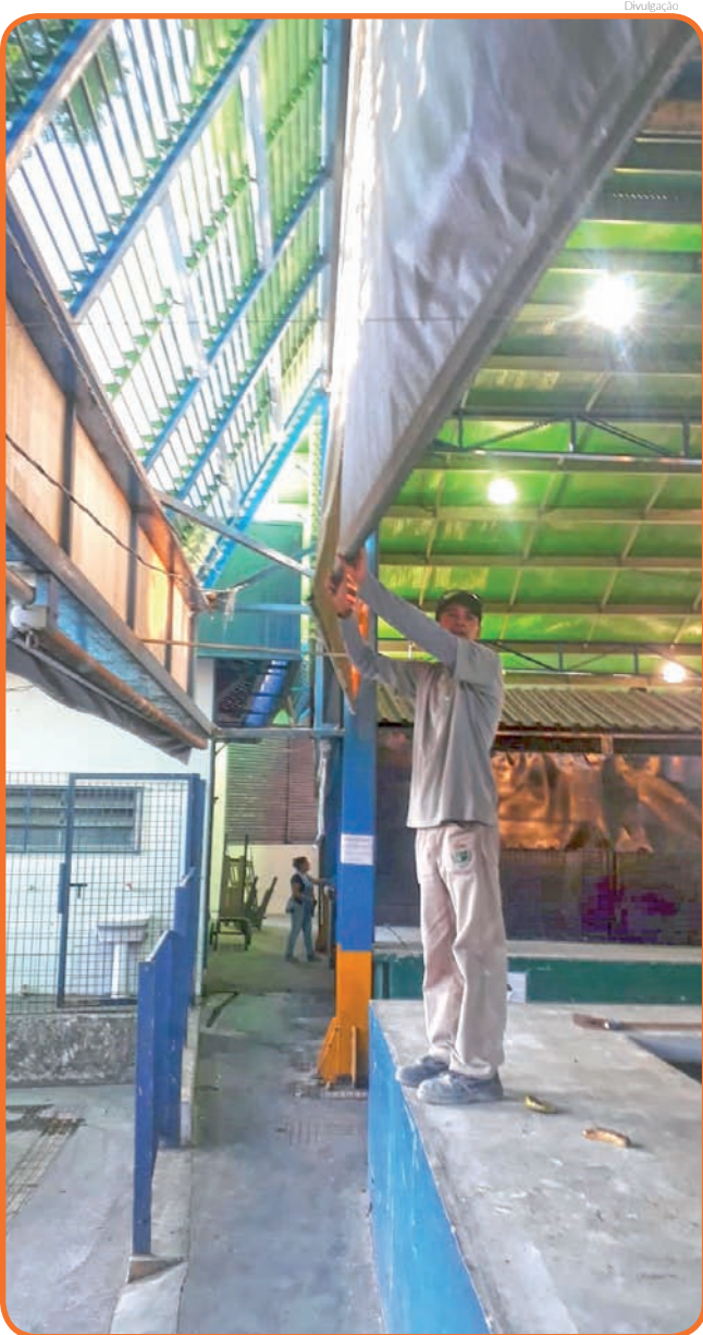
Toldos da Feira Coberta recebem manutenção
