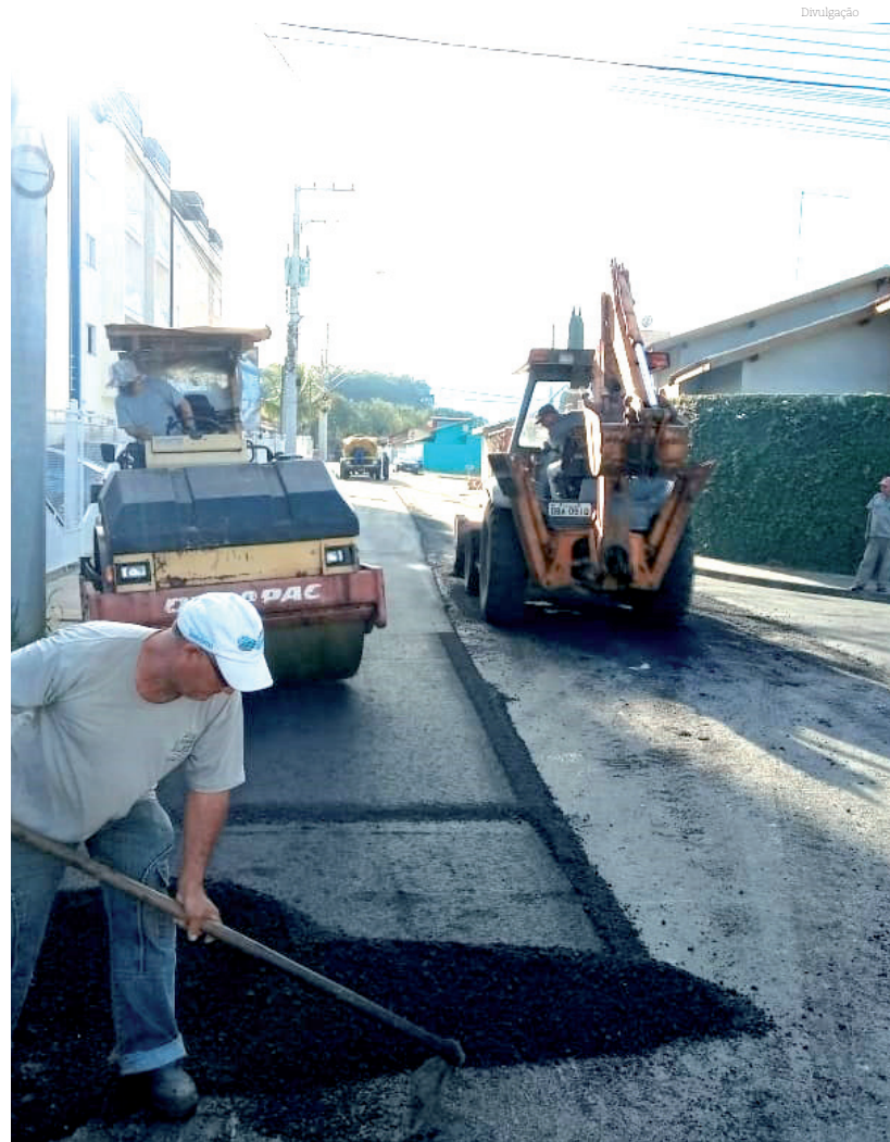
O trabalho de melhorias no piso asfáltico vem sendo realizado pelo Setor Usina de Asfalto
