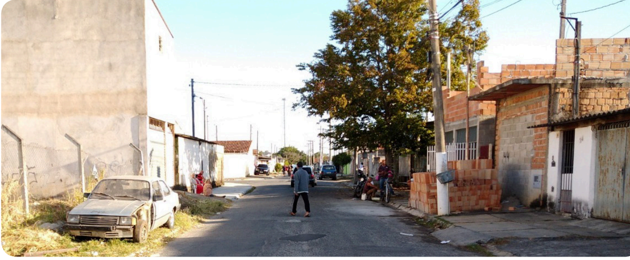
Projeto apresentado contempla obras de recapeamento asfáltico em 62 ruas e avenidas de Pinda
