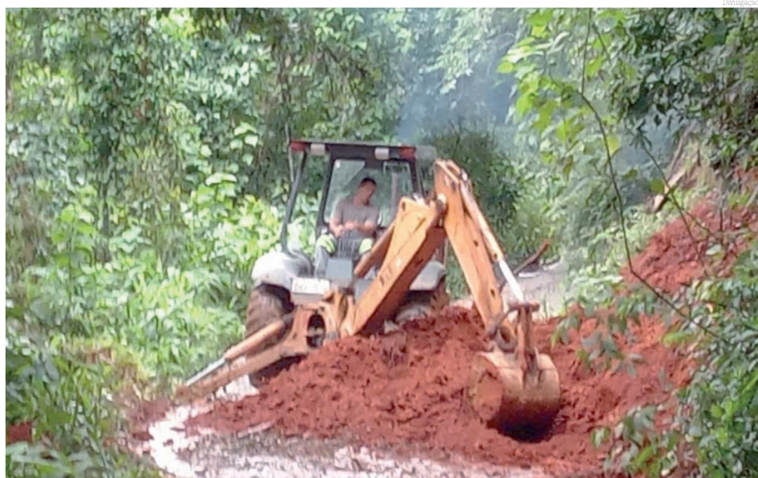
Os trabalhos de recuperação dos trechos afetados estão em andamento
